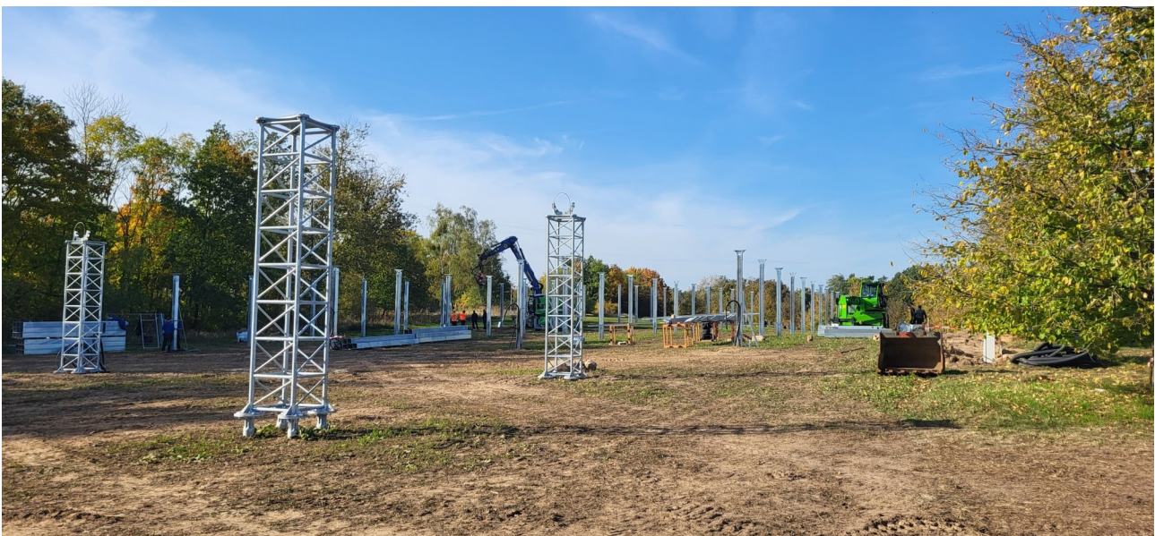
Bild: Bauarbeiten Agri-PV-Anlage ZALF Müncheberg, 17.10.2024
