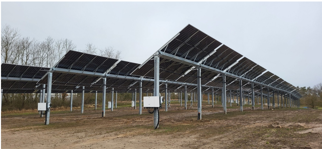
Bild: Agri-PV-Anlage auf Ramm-Fundamenten, ZALF Müncheberg, 31.01.2025
